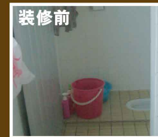
装修前 铺上马赛克地砖的蹲式厕所
